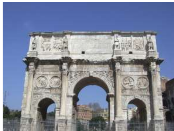
Arco di Costantino
